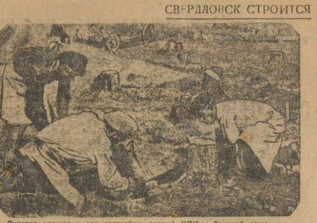
Очистка площадки для постройки зданий УПИ в Зеленой роще.
