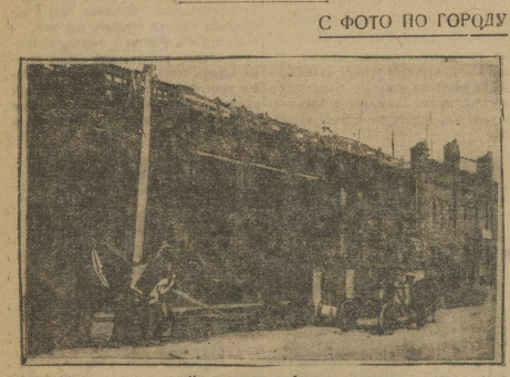
На ул. Малышева, рядом с Коммунальным банком, строится новое здание ГЭТа.
