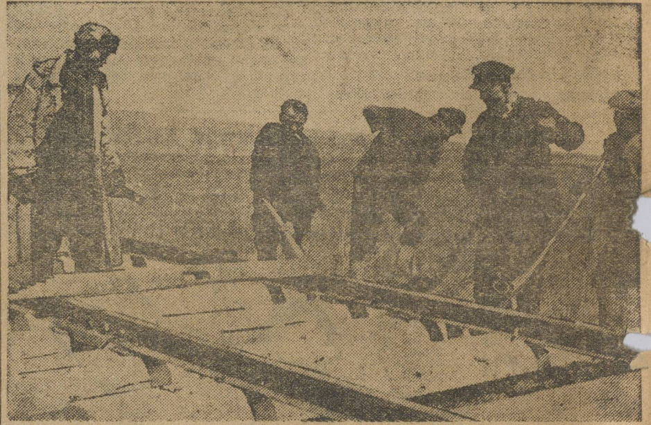
На постройке ж.-д. линии. Кварталы—Магнитная. Под'емка вновь укладенного полотна.
