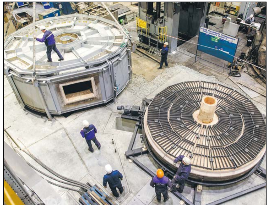
Установка корпуса уникальной и универсальной карусельной печи
