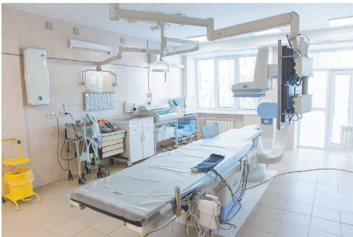
Обновленный ангиографический комплекс.
