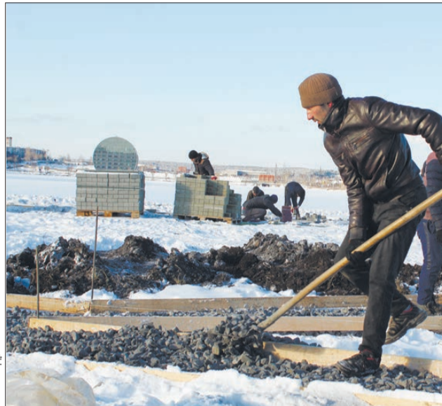
Плитку положили при температуре выше -15°C, что не нарушает технологию
