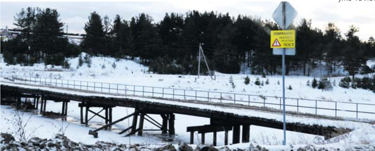
Мост через Нейву сельская администрация ремонтирует ежегодно
