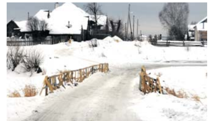
Мост в районе деревни Карпихиной построен примерно в 1983 году для нужд совхоза. В минувшем году его настил восстановили и сделали деревянное ограждение. Но современным ГОСТам он всё равно не соответствует
