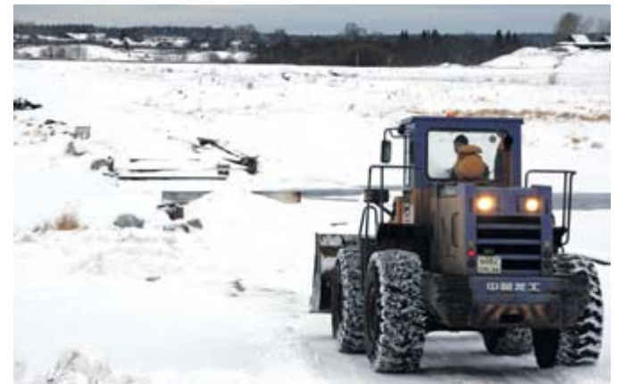
В центре посёлка Махнёво мост закрыт уже четвёртый месяц
