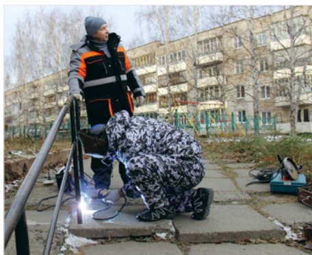
Сварщики Илья Левин и Сергей Леушин смонтировали лестницу в считанные часы
