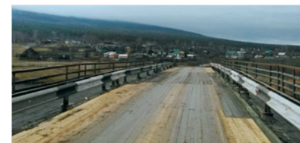
В следующем году ремонт будет продолжен
