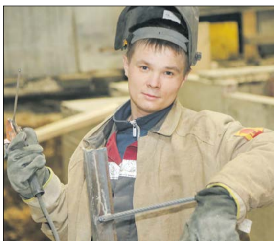
Сварщик Максим Степанов готовит арматурную сетку
