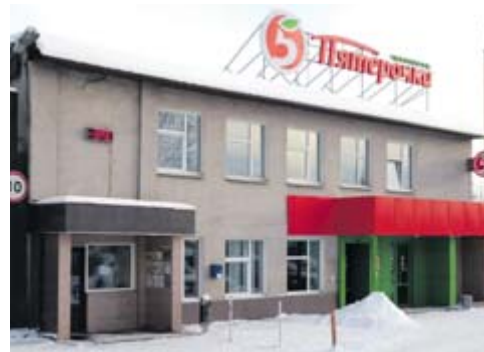
В прошлом году, проработав более полувека, столовая закрылась, а помещение переоборудовали под сетевой магазин «Пятёрочка».
