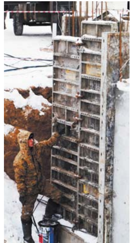
Идет монтаж опалубки
