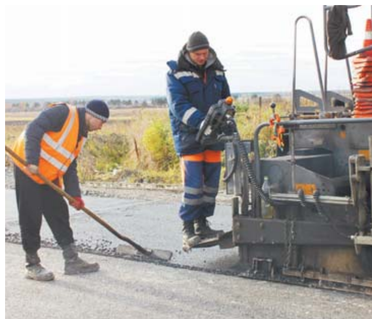
Идет укладка асфальта
