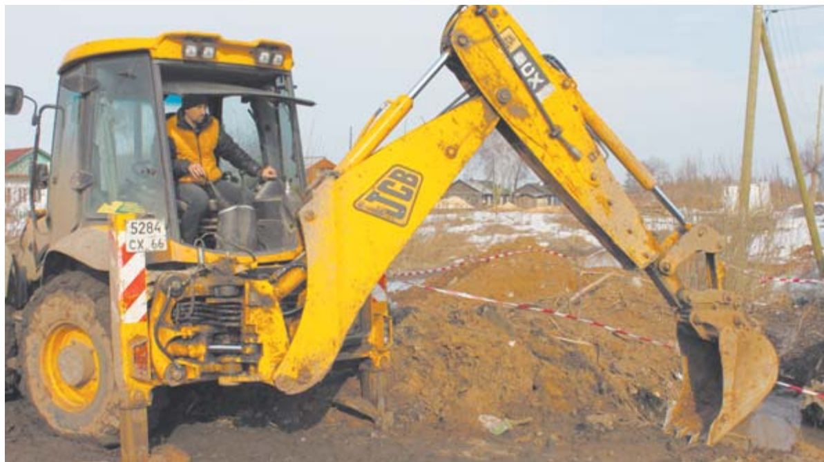
Строительство газопровода идёт полным ходом
