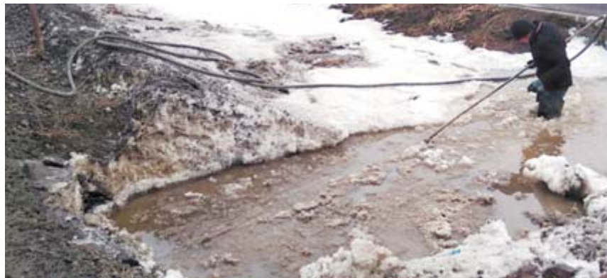
Идёт очистка водопропускных труб и канав силами ООО «ДСК»
