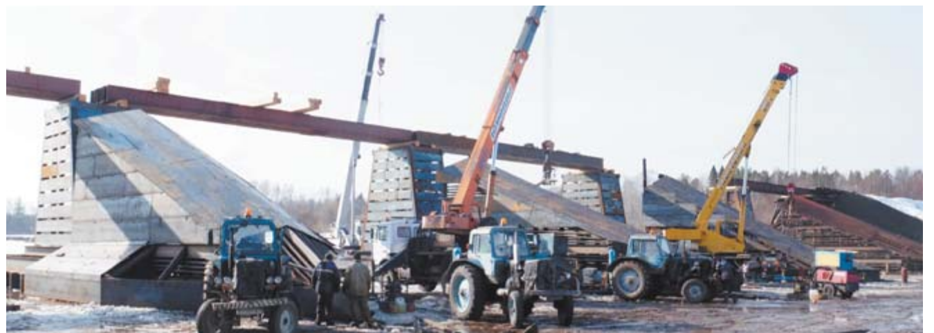
Техника работает по льду, толщина которого более метра
