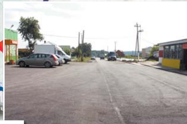
На перекрёстке улиц Ленина и Перминова между магазином «Монетка» и кулинарией заасфальтирована площадка.
