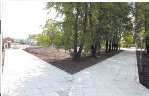
В сквере у Напольной школы заканчиваются работы по укладке плитки на пешеходных дорожках
