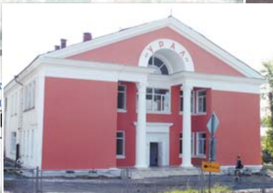
Отремонтирована лицевая часть фасада досугово-молодёжного центра «Урал»
