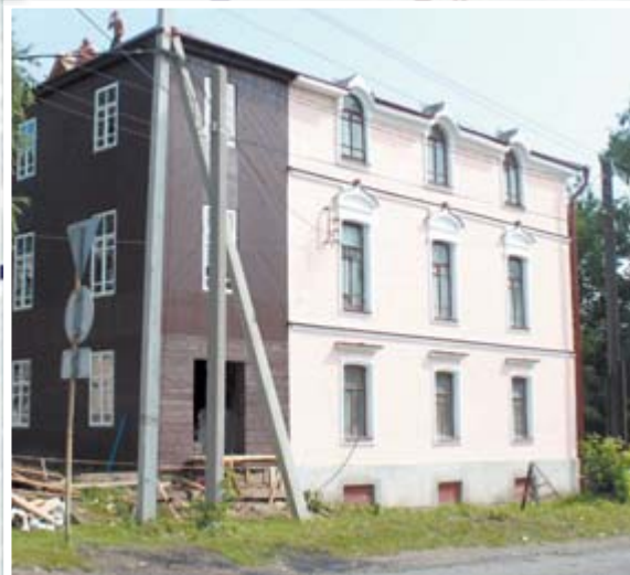
Заканчивается ремонт фасада и крыши исторического здания алапаевского краеведческого музея, известного как дом инженера И.Е. Софонова
