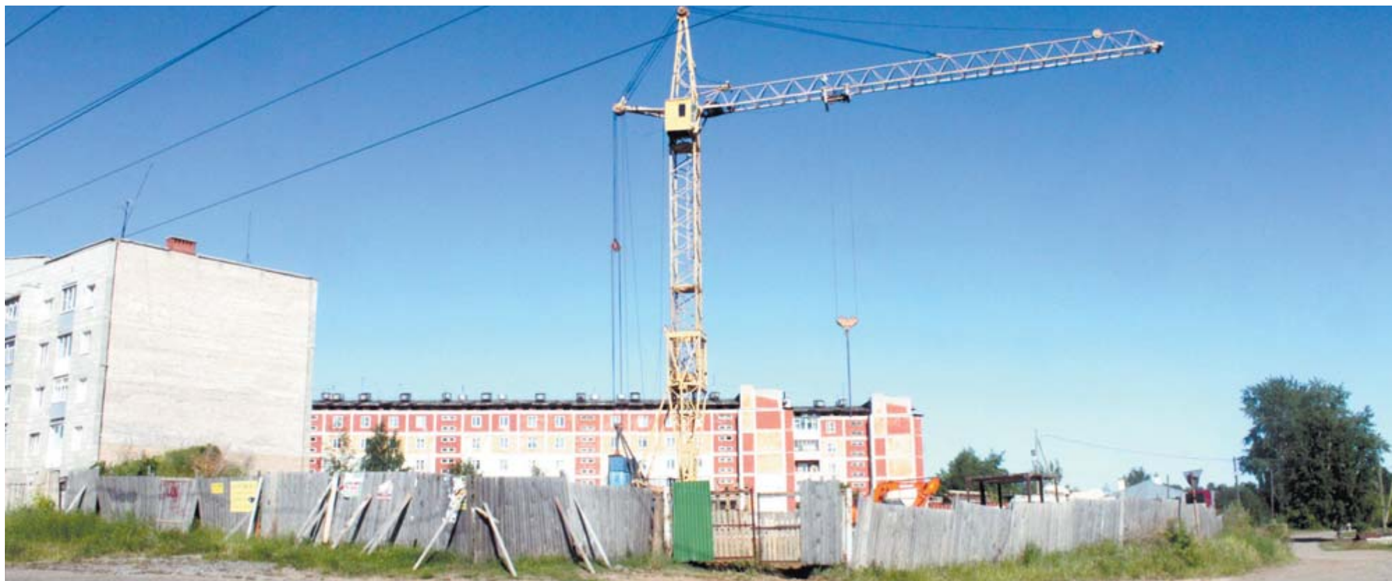
Строительство дома на углу улиц Н. Островского и Красина
