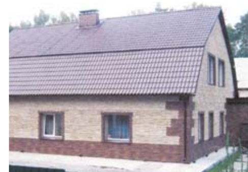
Внешняя отделка дома выполнена строительной бригадой ТД «Сенат»
