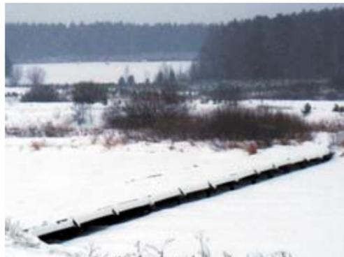
Низководный мост в селе Кировском обеспечивает автомобильное сообщение с противоположным берегом реки Нейвы, на котором находятся деревни Молокова и, в пяти километрах восточнее, Елань. Мост старый, затопляемый, требует капитального ремонта.
