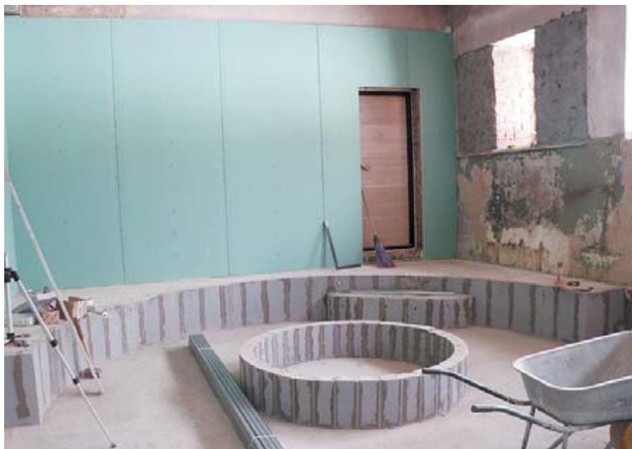
Идет ремонт в бане по ул. Перминова. Здесь будет фонтан...
