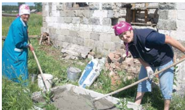
■ На стройке работали даже женщины
