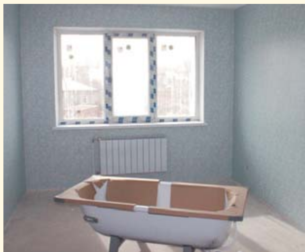
В квартирах устанавливают сантехнику
