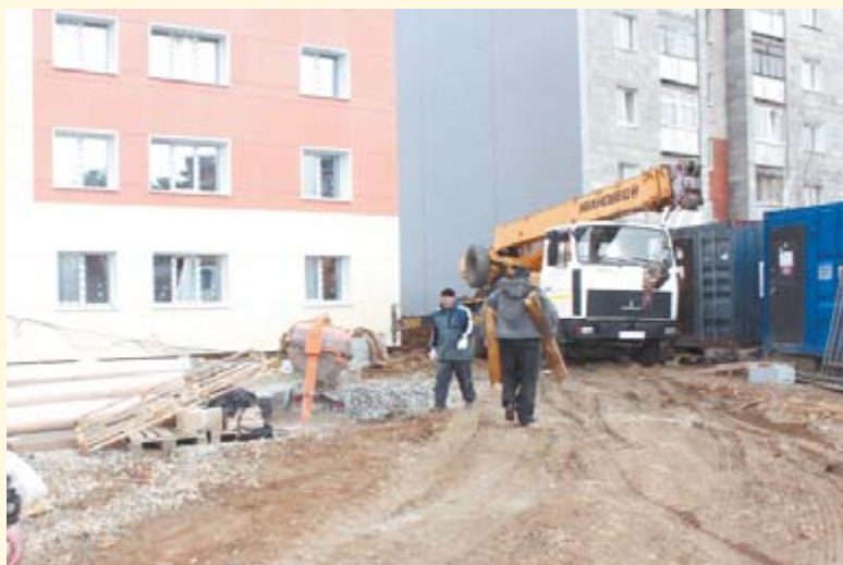
Строители приступают к благоустройству придомовой территории
