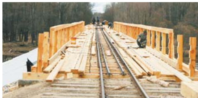
Новый мост на реке Туре
