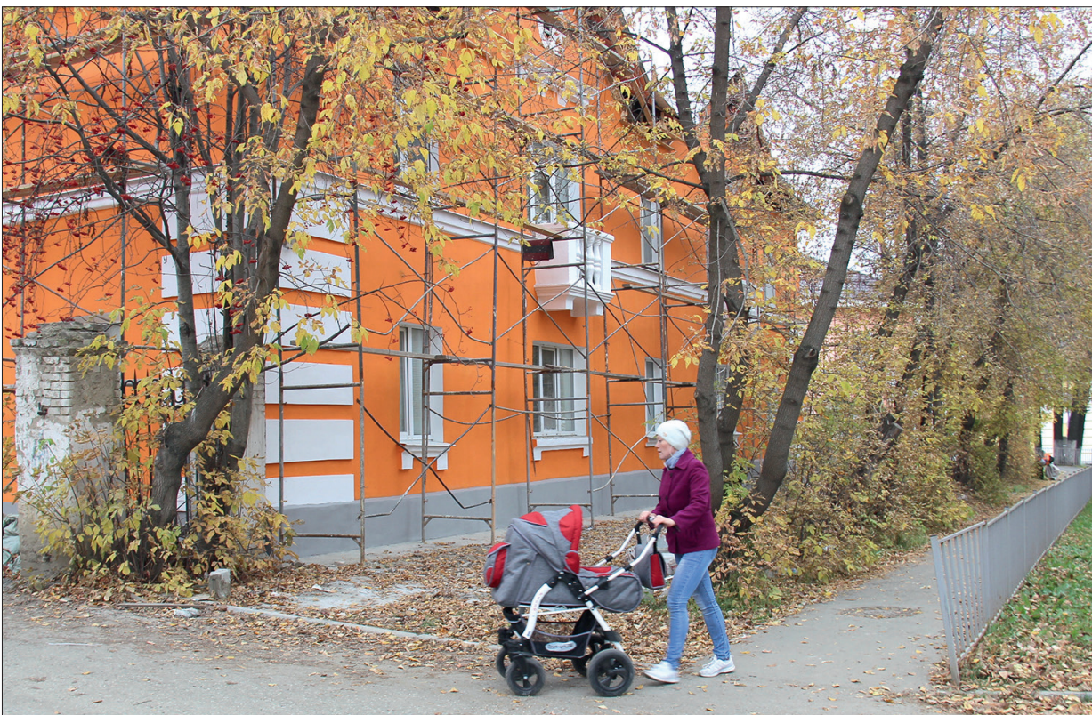
На улице Пирогова завершаются фасадные работы в домах 2, 4 и 8 / ФОТО РЕДАКЦИИ ГАЗЕТЫ "ВРЕМЯ"
