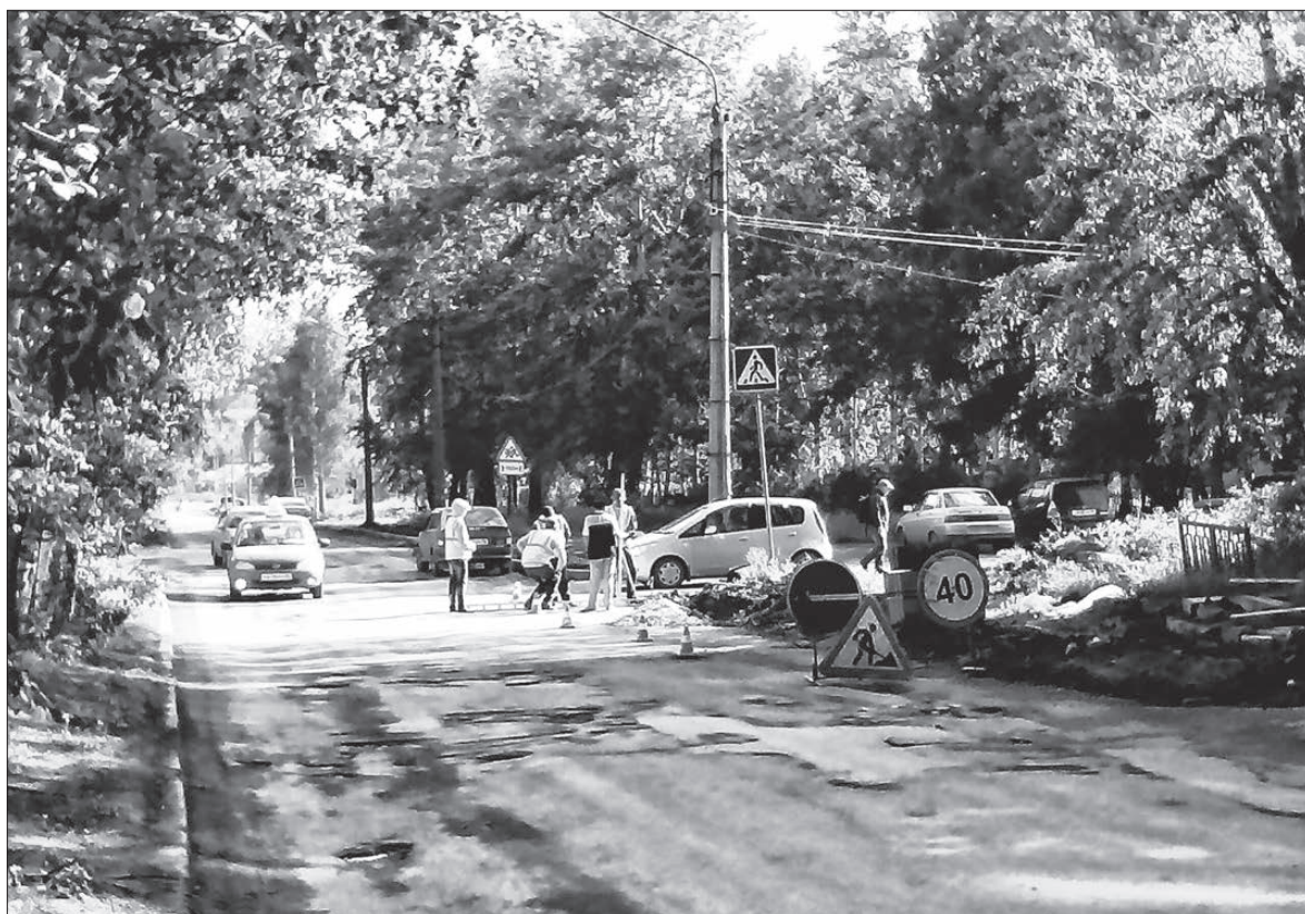
Этот участок дороги по улице Скорынина – один из немногих, где можно нормально ездить. В 2015 году здесь установили новые бордюры, отсыпали дорожной срезкой тротуары, устроили стоянки для автотранспорта, а также уложили новый асфальт / ФОТО ИЗ АРХИВА РЕДАКЦИИ ГАЗЕТЫ «ВРЕМЯ»
