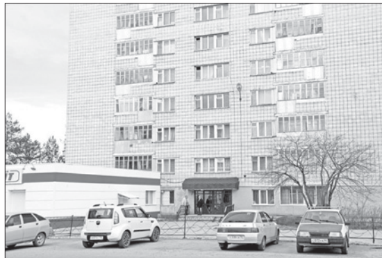
После реконструкции здесь будет 26 двухкомнатных и 16 трехкомнатных квартир / ФОТО РЕДАКЦИИ ГАЗЕТЫ «ВРЕМЯ»
