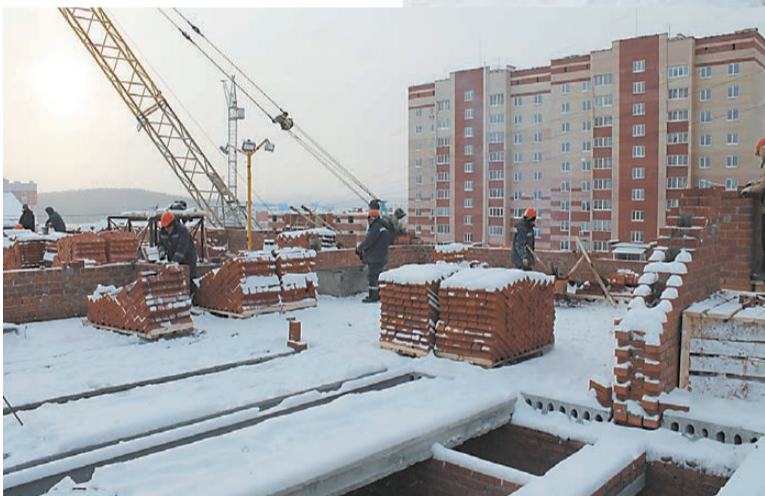
В Запрудном заканчивается строительство первого этажа.
