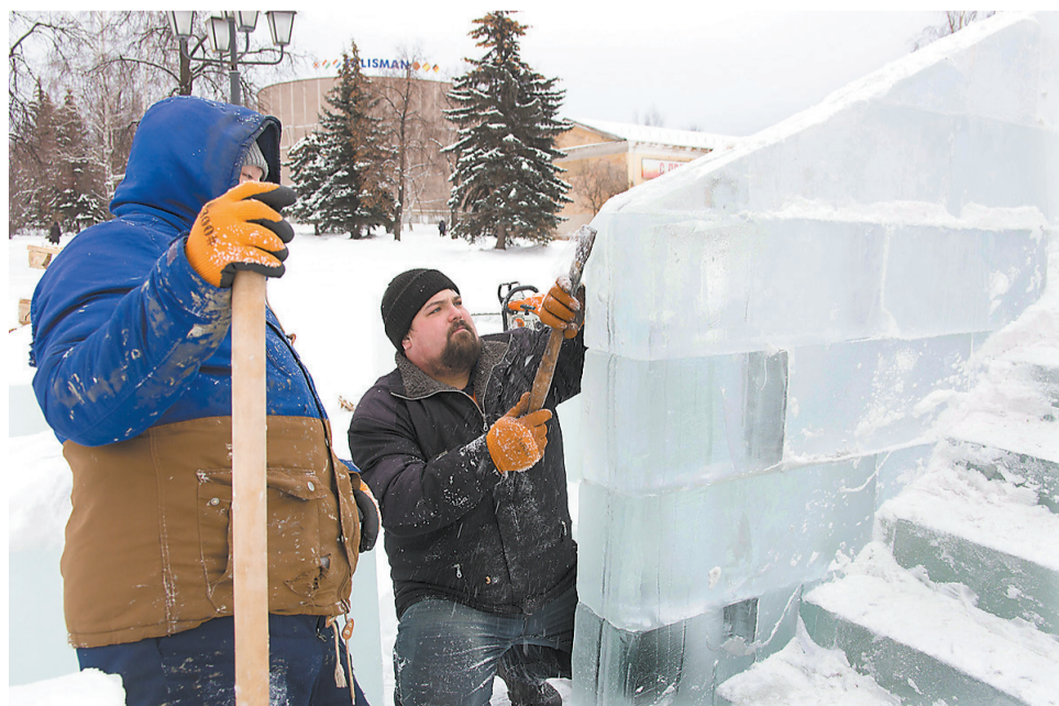
Строительство горки на Комсомольской площади.
