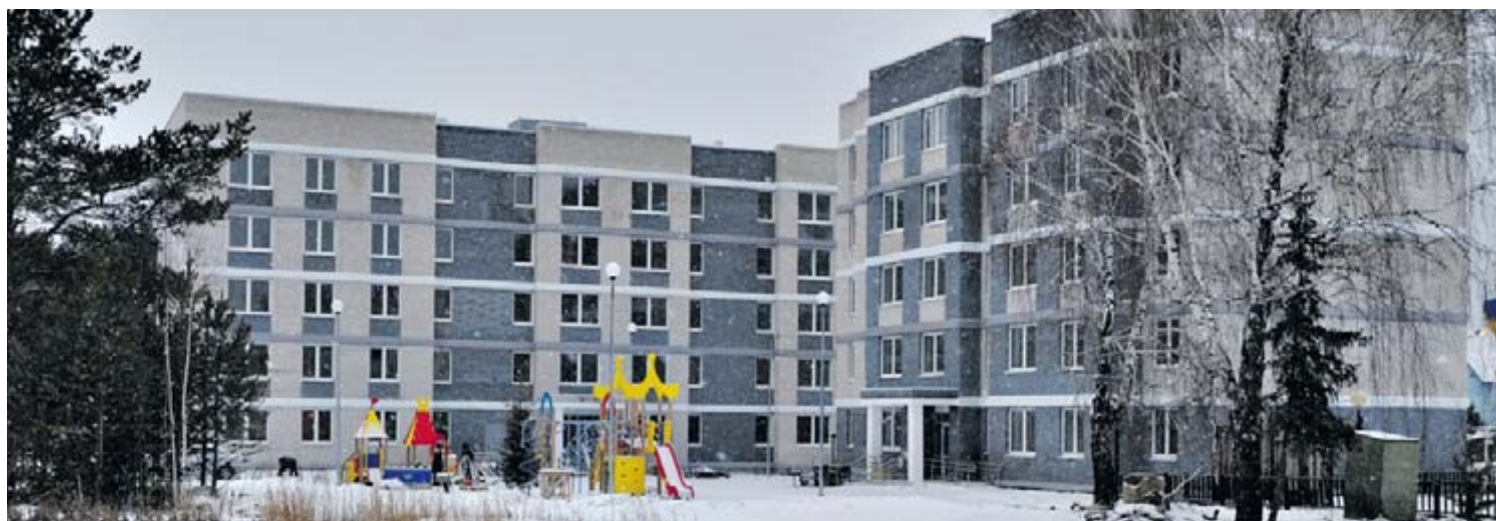
Новый 81-квартирный дом в Верхней Синячихе
