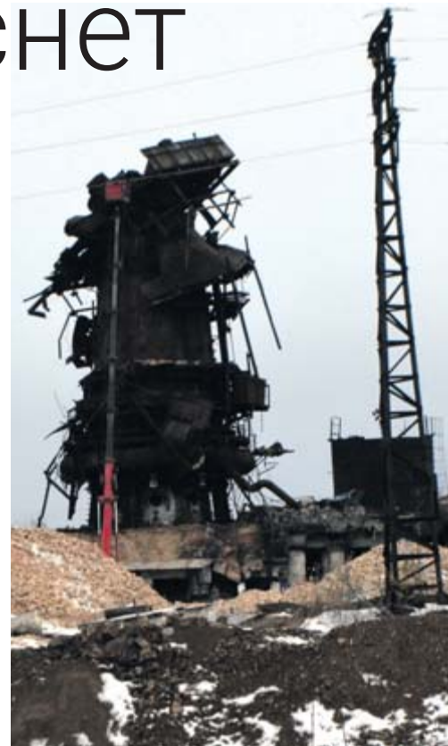
Продолжается демонтаж домны
