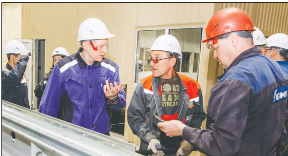
Владимир Соловьёв, инженер по реконструкции цеха № 16 и Павел Жилин, монтажник компании «ВИА Рус»
