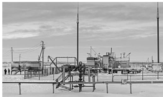
МКУ на кустовой площадке шестого газового промысла успешно прошла все испытания.
