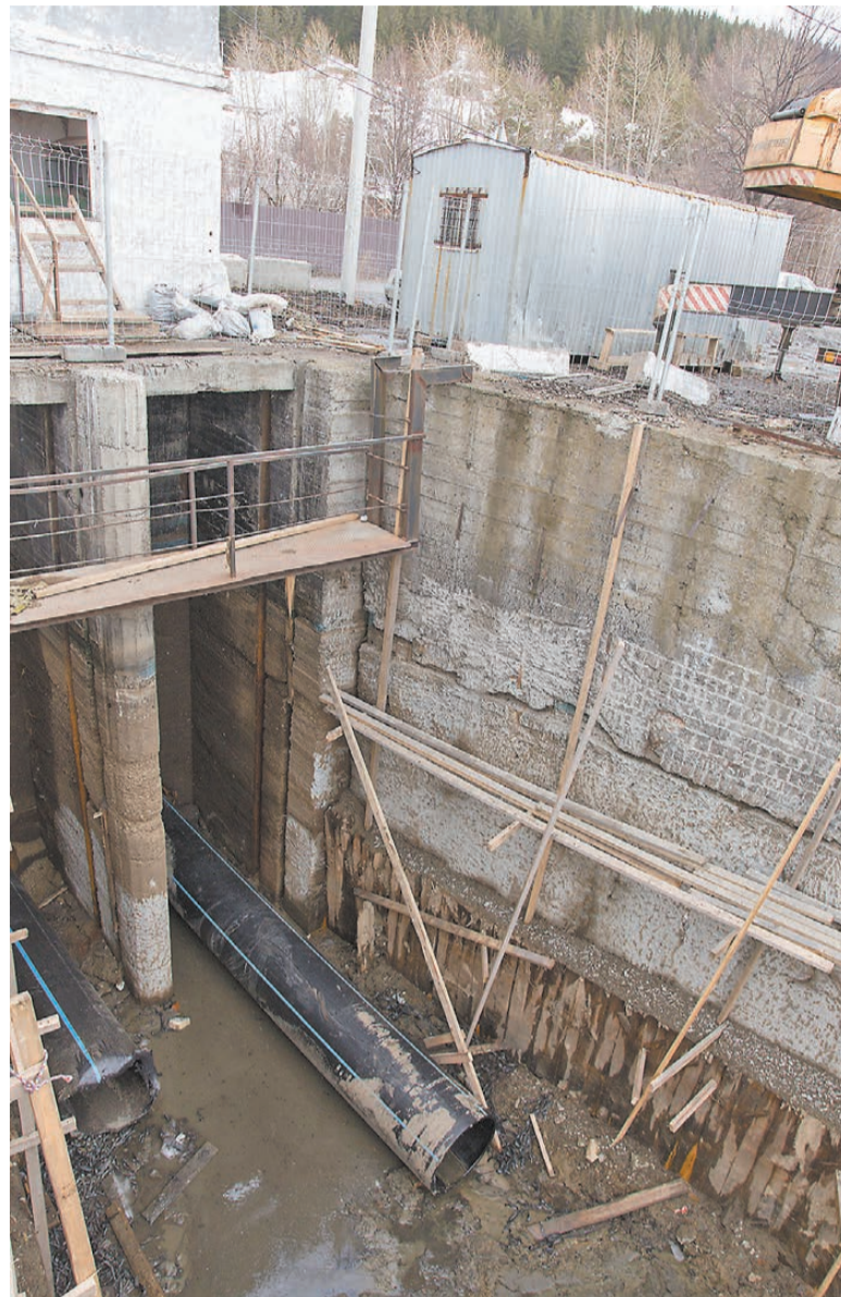
Плотина в разгар ремонта.
