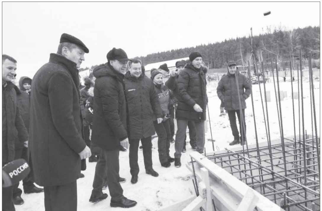
На память потомкам - шайбу в фундамент Ледового комплекса. Фото: пресс-службы губернатора
