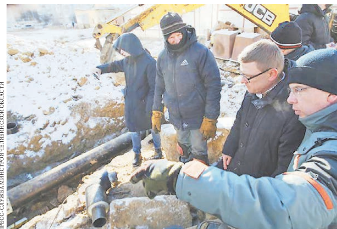
Ремонт теплосетей осложнил суровый уральский климат.
