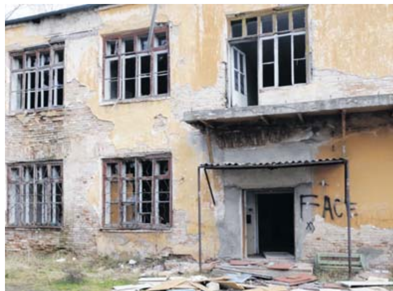
Главный корпус. Инфекционное отделение
