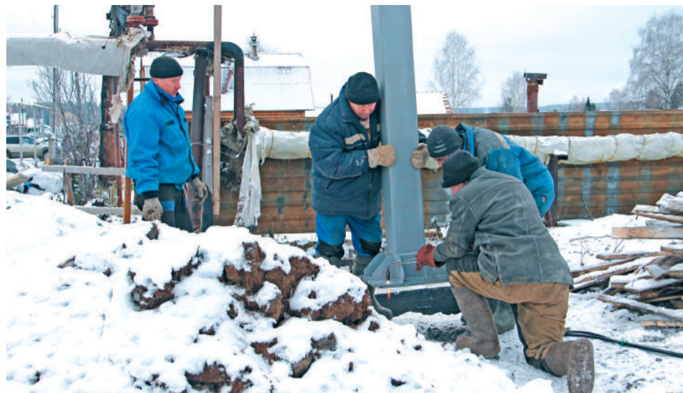
На сегодняшний день специалисты пробурили на объекте девять скважин для свай, смонтировали опоры тепловой сети, ведутся работы по монтажу и сварке труб.
