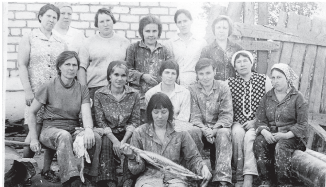
1977 г. Бригада на строительстве 66-квартирного дома в г. Талице.
