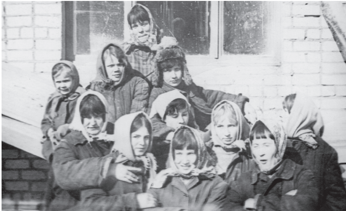
1971 г. Бригада на строительстве 40-квартирного дома в г. Талице.
