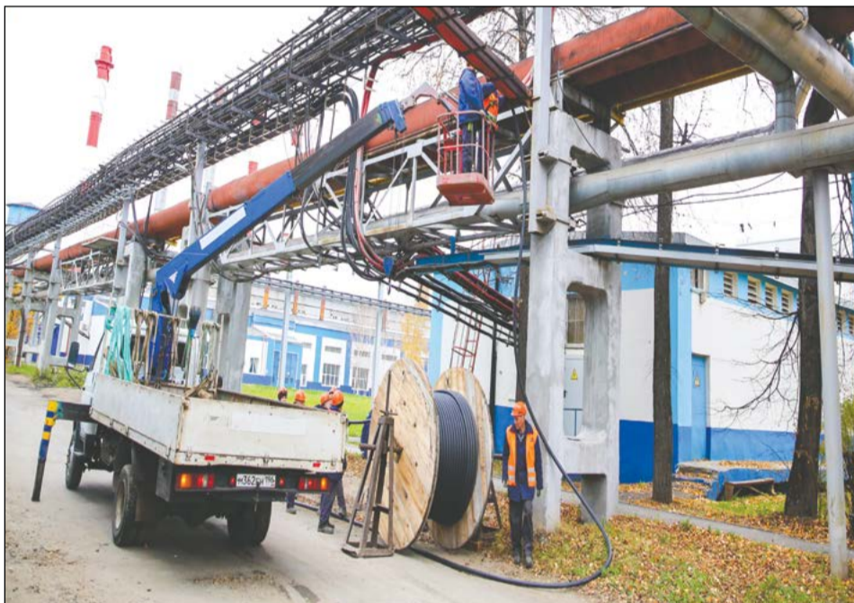
Вот из такого барабана кабель вручную укладывают на эстакаду
