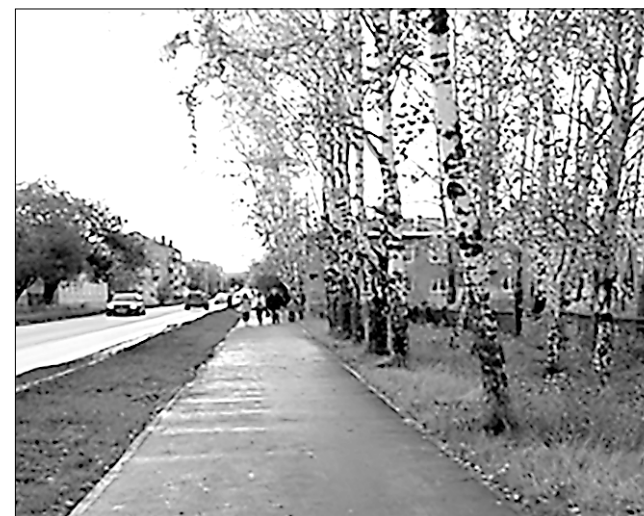
На улице Победы выполнены работы по ремонту тротуаров и пешеходных дорожек
