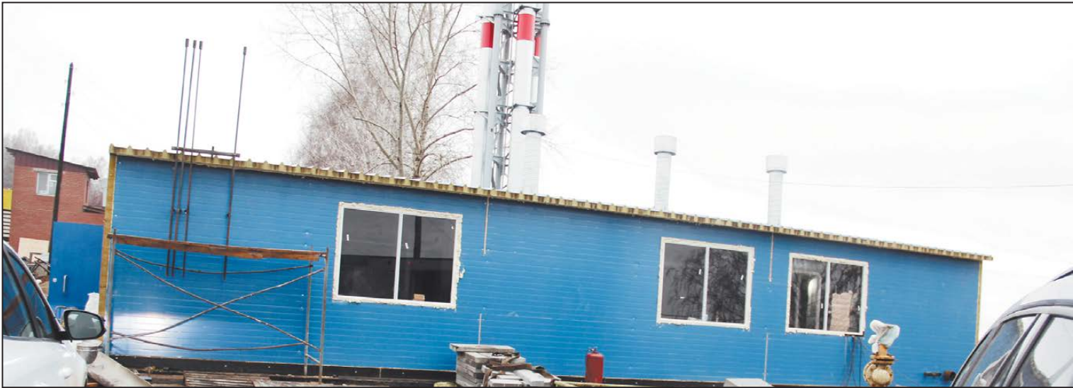
Строится новая котельная
