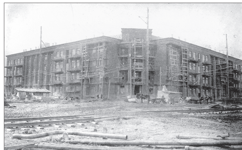
Строительство дома №2 на улице Сталина. Дом сдан в 1939 г.
