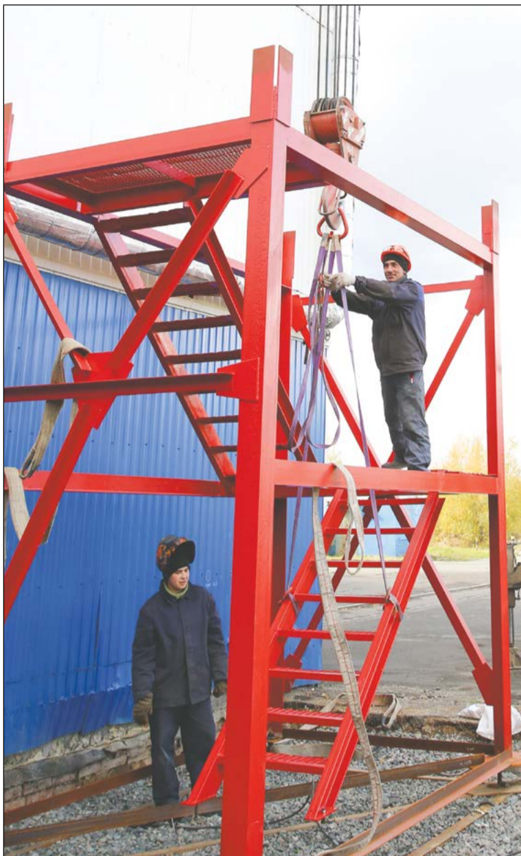
Погода благоприятствует оперативному монтажу секций маршевых лестниц
