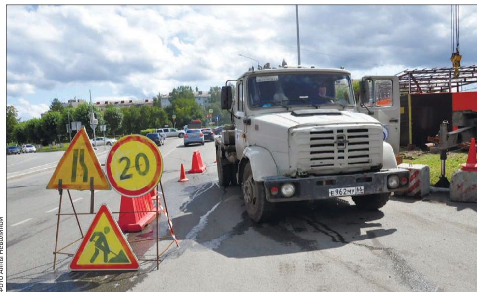
На время ремонта у ТЦ «Строитель» проезд не перекрывали
