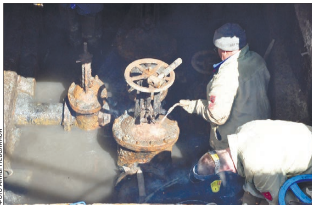
Новую задвижку помещают в обновленную камеру
