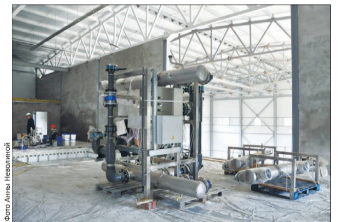
НФС: новый фильтр на втором этаже готов к монтажу
