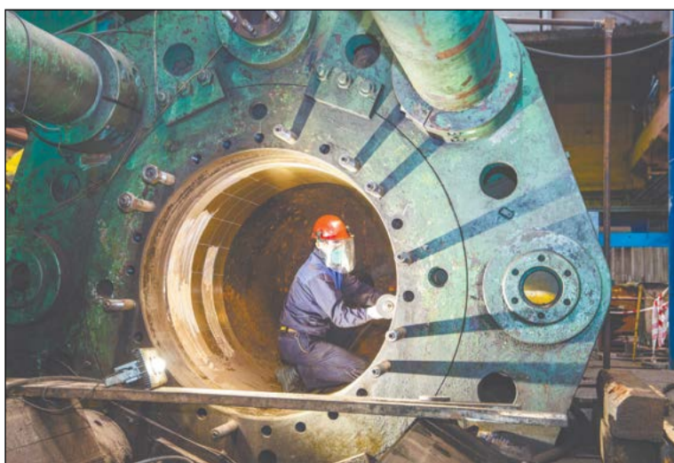
Перед установкой плунжера поверхность цилиндра доводят до нужных параметров с помощью шлифмашины
