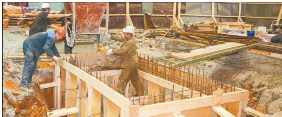
Специалисты фирмы «ДэксаСтрой» принимают первую порцию бетона для заливки прямки
