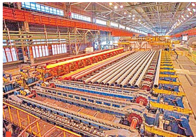
Современный трубопрокатный цех Северского трубного завода
