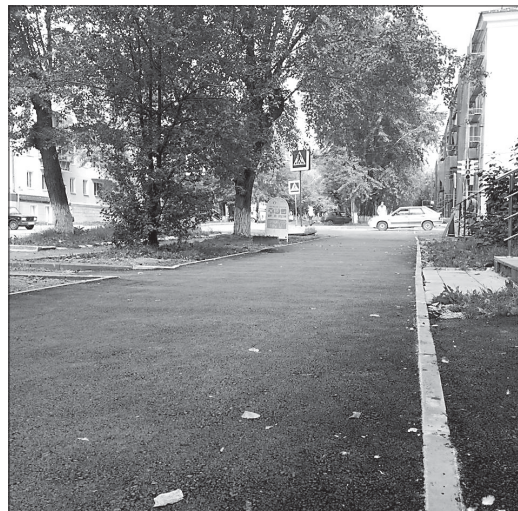
В районе дома № 6 на улице Ленина уже завершены
