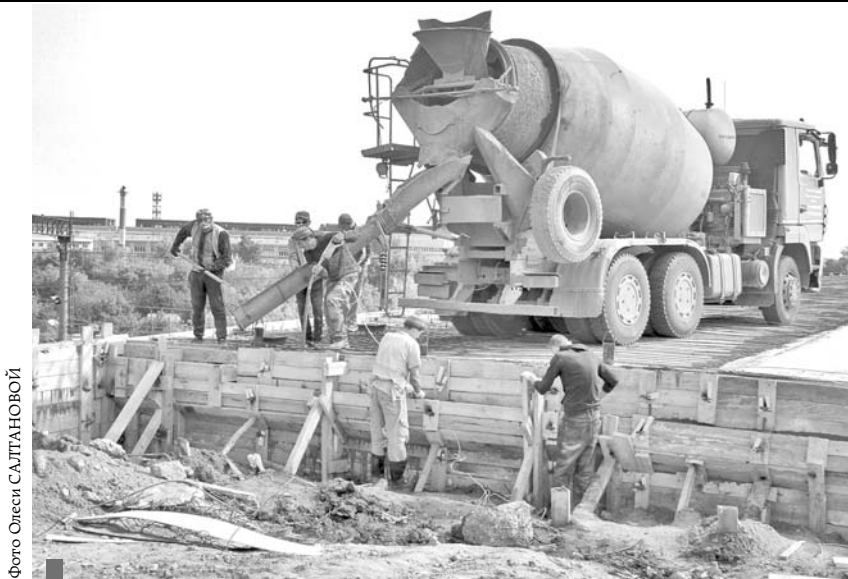
Бетонирование второй шкафной стенки
