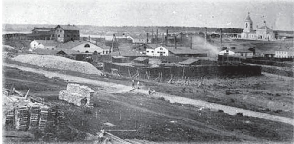
Посёлок Верхняя Синячиха в начале XX века
