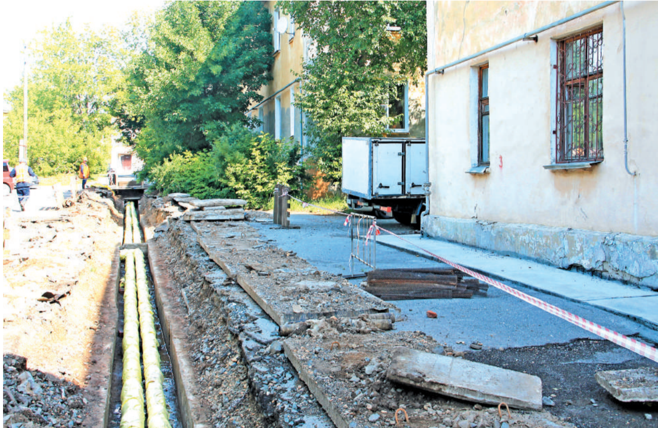
На отрезке между домами №№ 5 и 7 по улице Гоголя выполнены земляные работы, демонтирован прямой и обратный трубопровод, выполнен монтаж обратного трубопровода.
