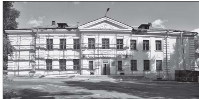
Школа № 15 в строительных лесах
